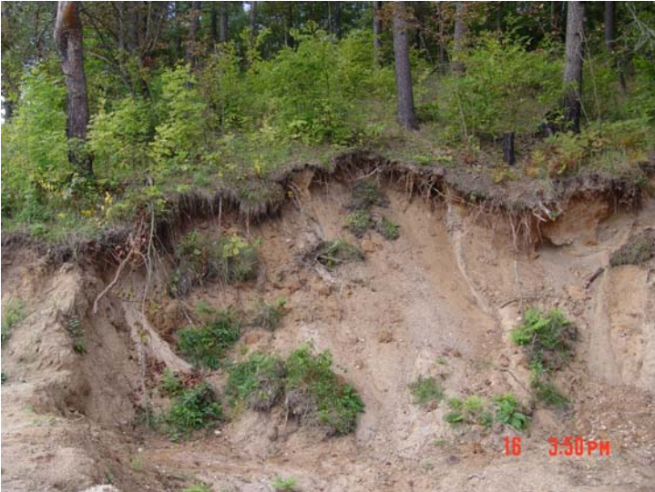
14 pav. Žemės savininkas nubaustas už aplinkosaugos reikalavimų pažeidimą dėl iškastos pamatų duobės pastatui statyti neturint leidimo, tačiau pažeidimo pasekmė iki šiol nepašalinta (nuotrauka kairėje).
