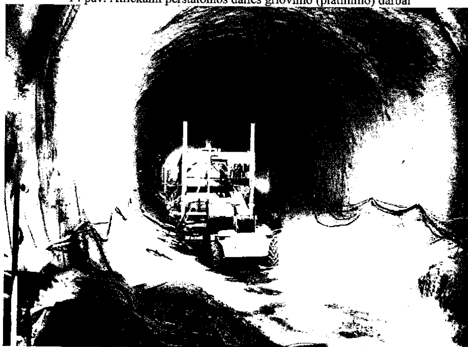
15 pav. Baigtas torkretuoti išorinis kevalas perstatomoje dalyje
