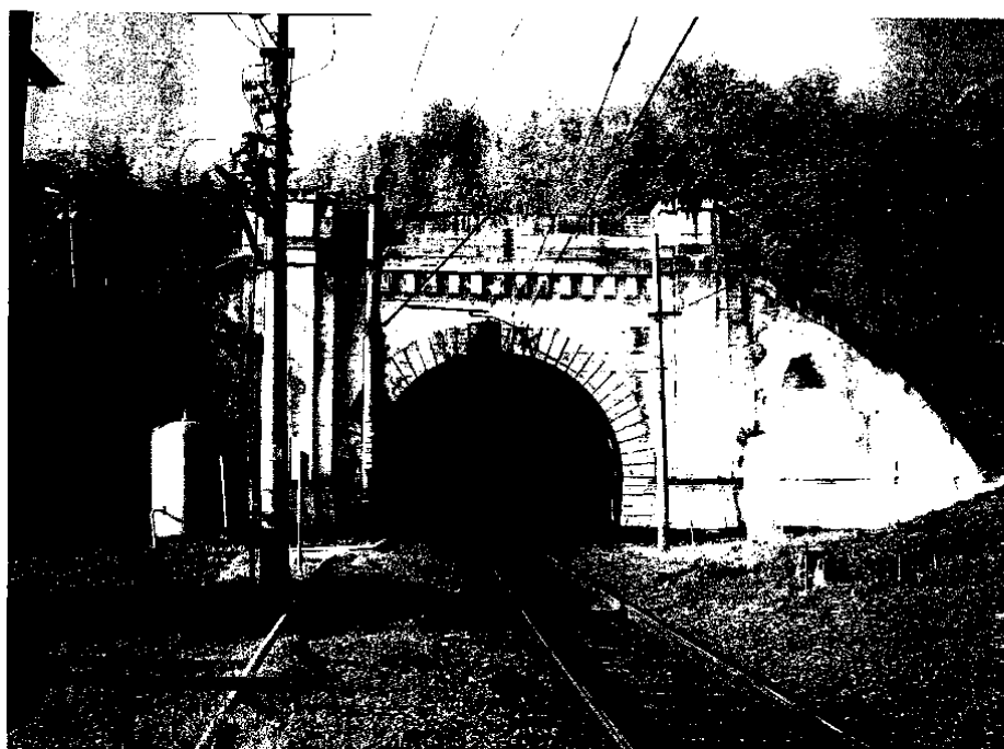
10 pav. Kauno geležinkelio tunelio rytinis portalas prieš rekonstrukciją
