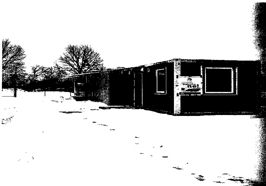
14 pav. Prienų stambiųjų bei kitų atliekų surinkimo aikštelės tarnybinis pastatas
