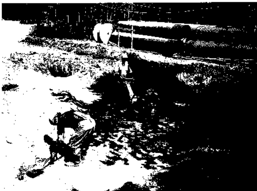
3.10. pav. Atvedamojo \varnothing 500 mm vamzdžio statyba 2006 06 08.
