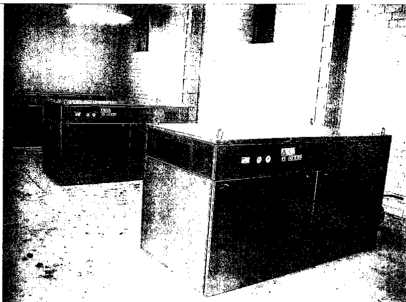
Orapūčių patalpoje sumontuotos orapūtės ir suspausto oro vamzdynai. 2006 m. lapkričio mėn.
