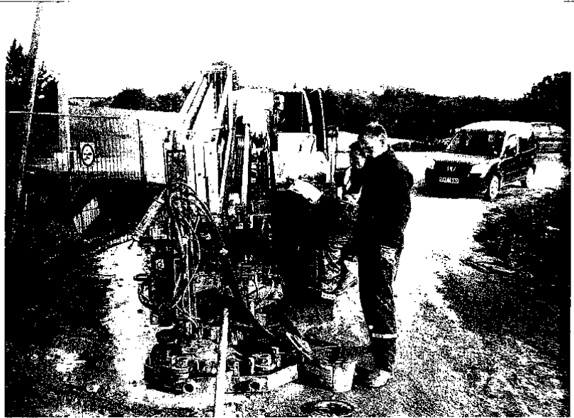
2.1.3.6. pav. Vykdomi nuotekų tinklų klojimo uždaru būdu darbai Lakštingalų gatvės kvartale, 2006 m. spalio mėn. pradžia
