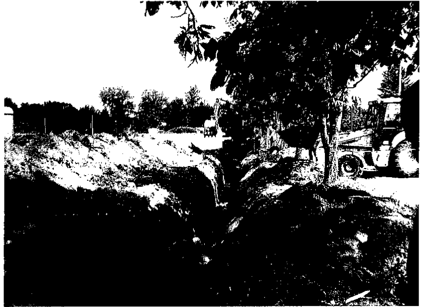
2.1.3.2. pav. Kasama tranšėja nuotekų tinklams Babėnų gyv. rajone Dariaus ir Girėno g. Rengiami vamzdžių pagrindai, 2006 m. gegužės mėn.
