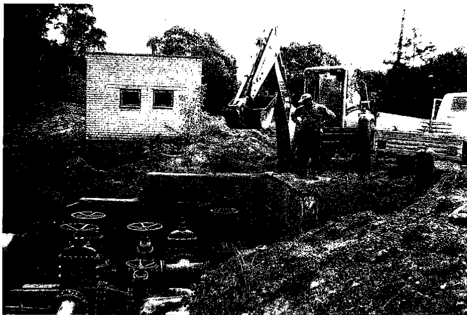
Vamzdyno pajungimas prie esamo vandentiekio tinklo rangovas -UAB „Kamesta“
