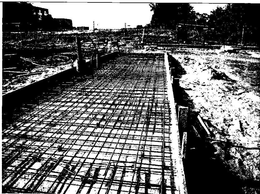
17 pav. Panevėžio stambiagabaričių atliekų aikštelė. Pamatų po tarnybiniais pastatais armavimas.
