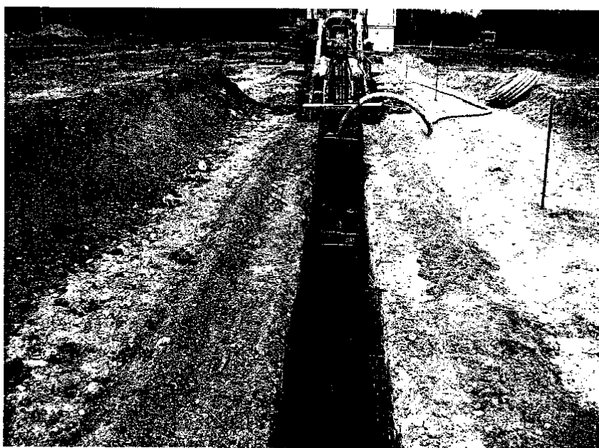
53 pav. Gruntinio vandens drenažo įrengimas (galutinų PVC vamzdinių 67/75 klojimas).
