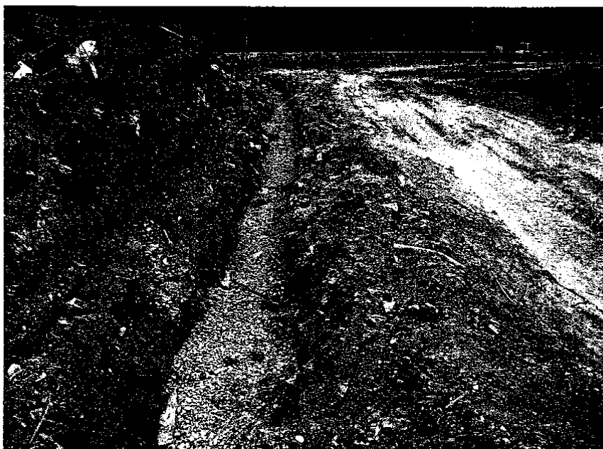
55 pav. Filtrato „ežero“ naujos darbo zonos filtrato drenažo įrengimas.
