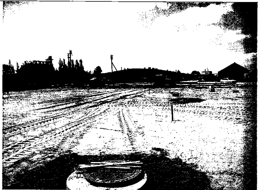
13 pav. Kupiškio stambiagabaričių atliekų aikštelė. Įrengiami pagrindai po asfaltbetonio danga.
