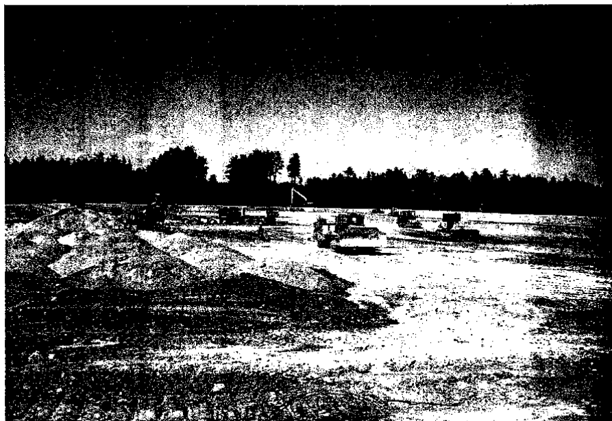
59 pav. Asbesto atliekų I-a sekcija.
