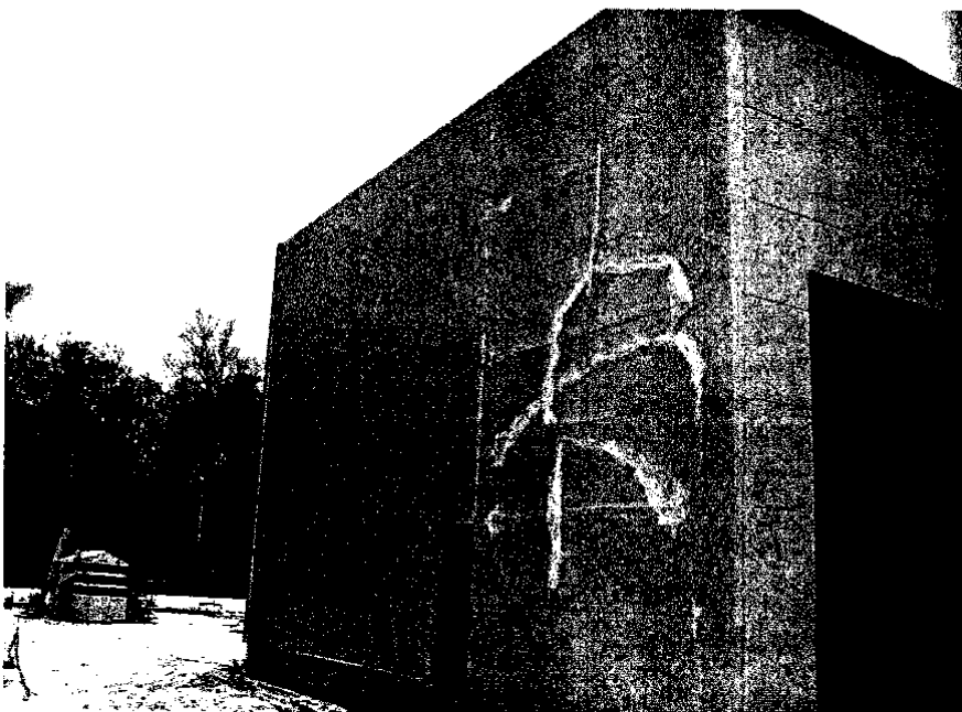
79 pav. Sieninių panelių montavimas garažo pastate.
