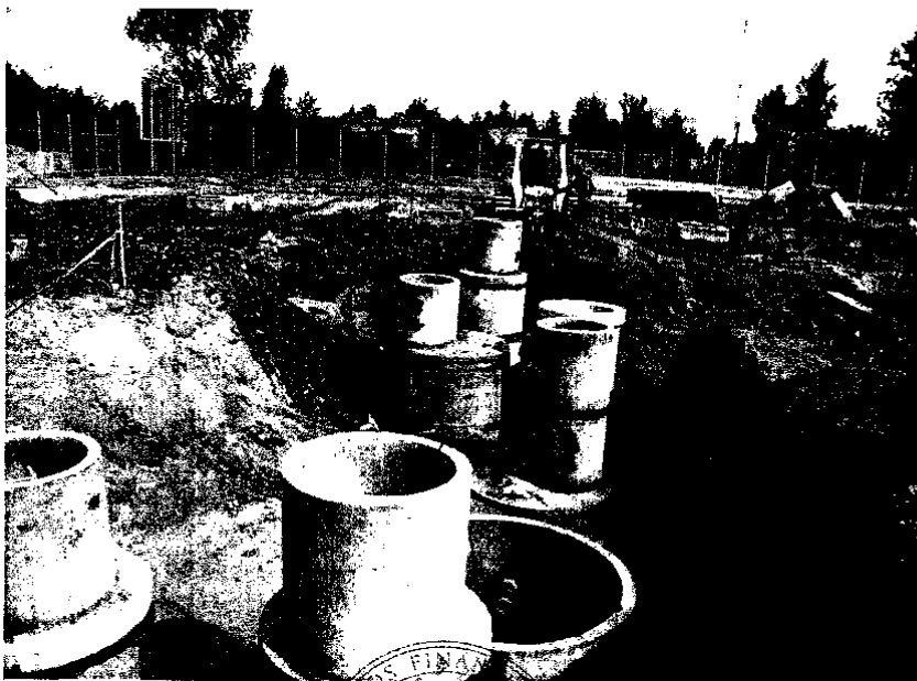
18 pav. Rokiškio stambiagabaričių atliekų aikštelė. Lietuvos nuotekų tinklo montavimas.
