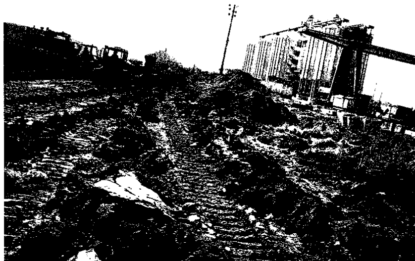
7 pav. Kupiškio stambiagabaričių atliekų aikštelė. Žemės darbai, teritorijos paruošimas.
