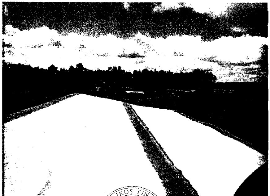
101 pav. Klojamas geosintetinio molio izoliacinis kilimas.
