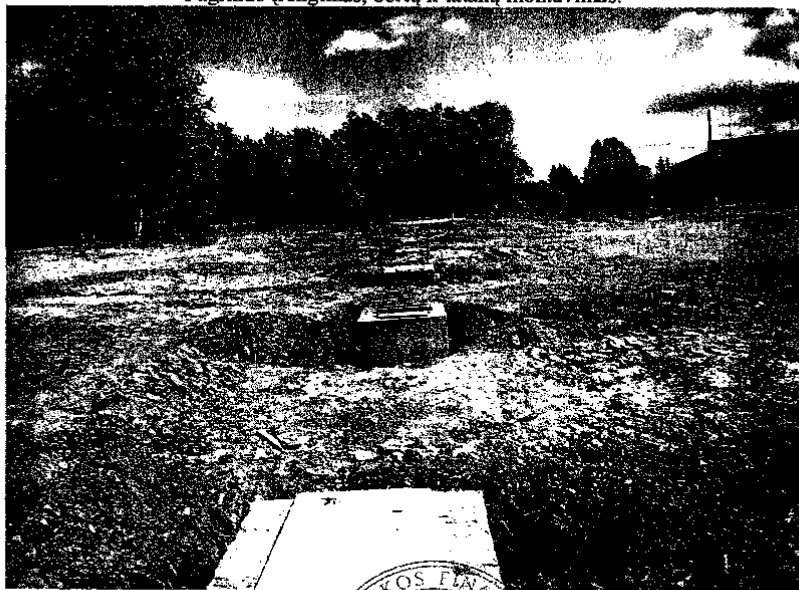
12 pav. Rokiškio perkrovimo stoties ir perkrovimo pastato pamatai.
