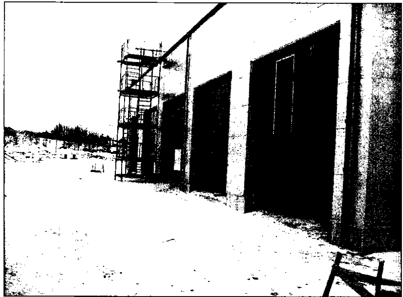
82 pav. Vartų montavimas garažo su remonto dirbtuvėmis pastate.
