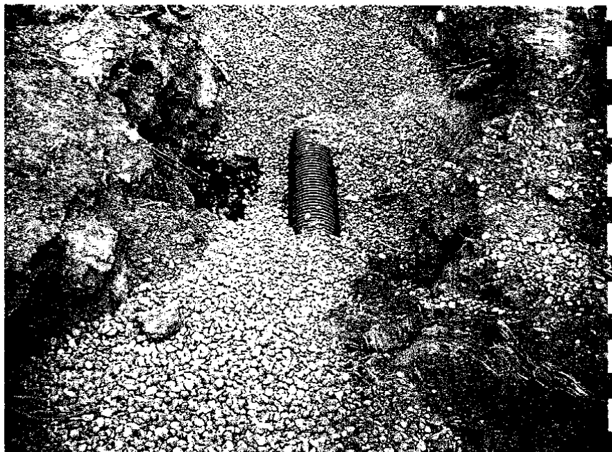
56 pav. Filtrato „ežero“ naujos darbo zonos filtrato drenažo įrengimas.
