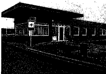
Tarnybiniam pastate įrengtos patalpos biurui, persirengimo kambariai, valgomasis, salė, tualetai, patalpa atliekų priėmimo-svėrimo operatoriui.
