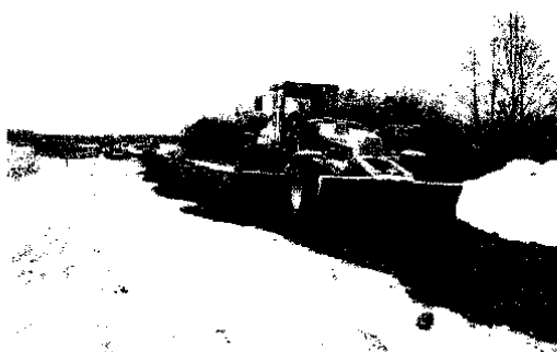
87 pav. Išstumdomas ir išlyginamas smėlio-žvyro mišinys
