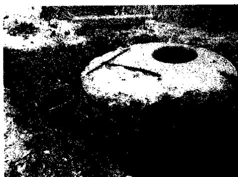
84 pav. Atkasti pakelės šuliniai
