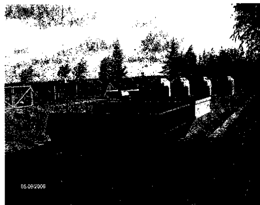
50 pav. APP su išstatytais konteineriais
