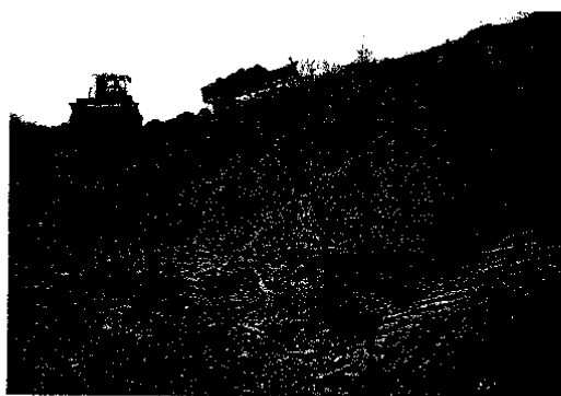
55 pav. Vakarinio šlaito užpylimas karjeriniu moliu ir molio perstūmimas
