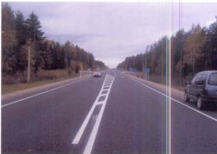
3.1.3.5 pav. Kelio A11 ruožas 69,6–79,1 km po rekonstravimo
