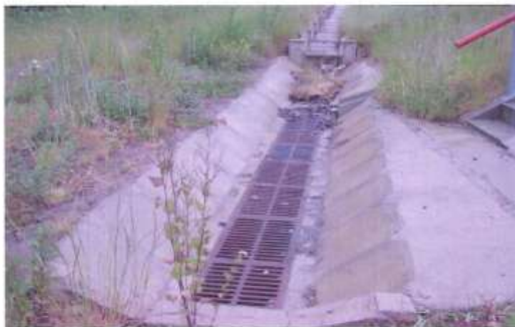
7.13 pav. Tiltas per Virvytę. Nuotekos nuo kelio nuvedimos latakais į šulinėlius-sėdintuvus.
