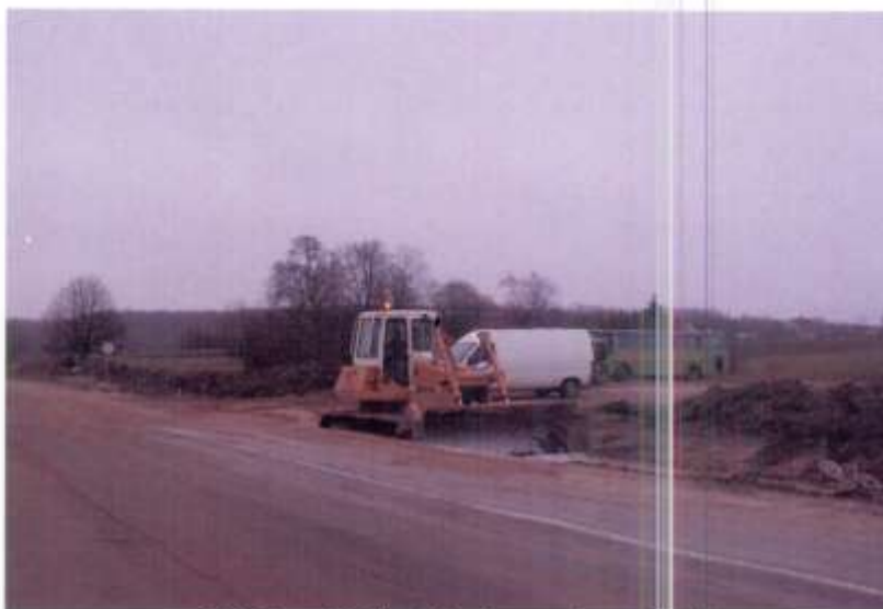
3.1.3.3 pav. Kelio A11 rekonstravimo darbai
