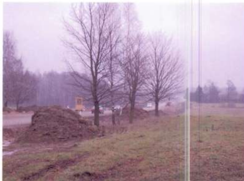
3.1.3.2 pav. Kelio A11 rekonstravimo darbai
