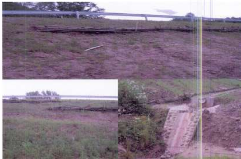
7.17 pav. 91,5 km, 92,5 km kelio dešinė. Supintos iš medžio šakų laikinos užtvaros suformuotos keliomis pakopomis: kelio sankasos viršuje, ties viduriu bei prie griovių ir latakų.
