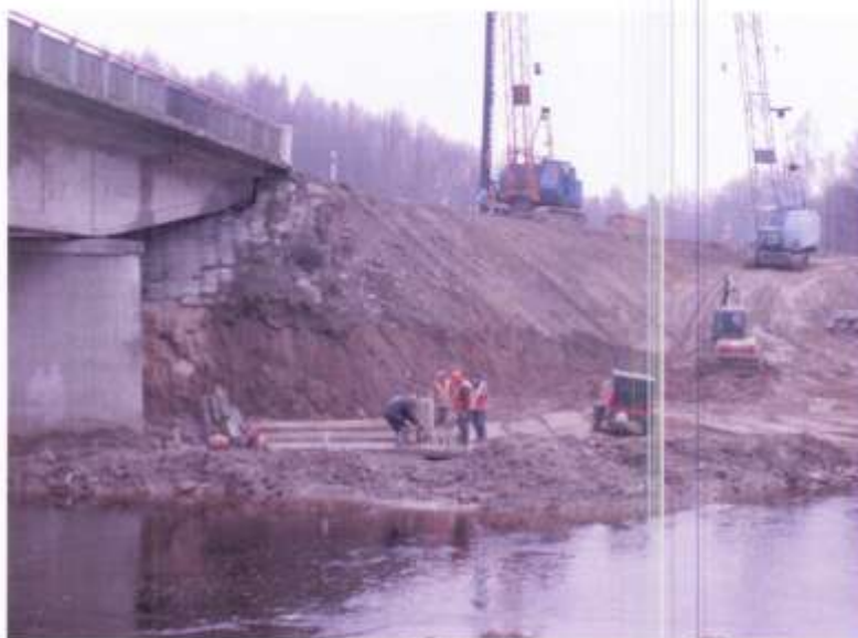
3.1.3.4 pav. Tilto per Miniją rekonstravimo darbai
