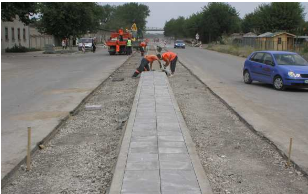
3.1.3.2 pav. Liepų g. rekonstrukcijos darbai
