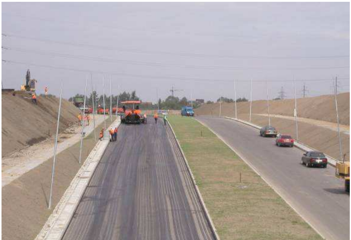
3.1.3.1 pav. Šiaurės prospekto tiesimo darbai
