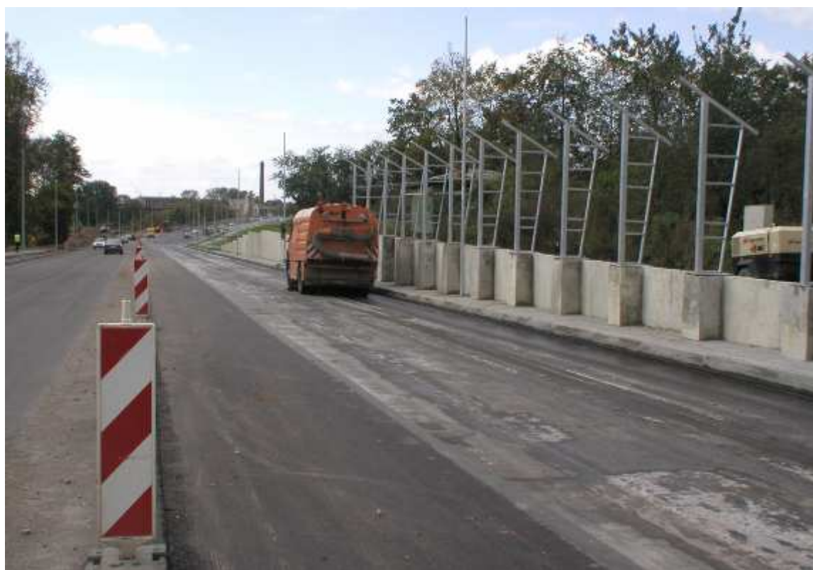
3.1.3.5 pav. Triukšmo slopinimo sienutės įrengimo darbai (Liepų g.)
