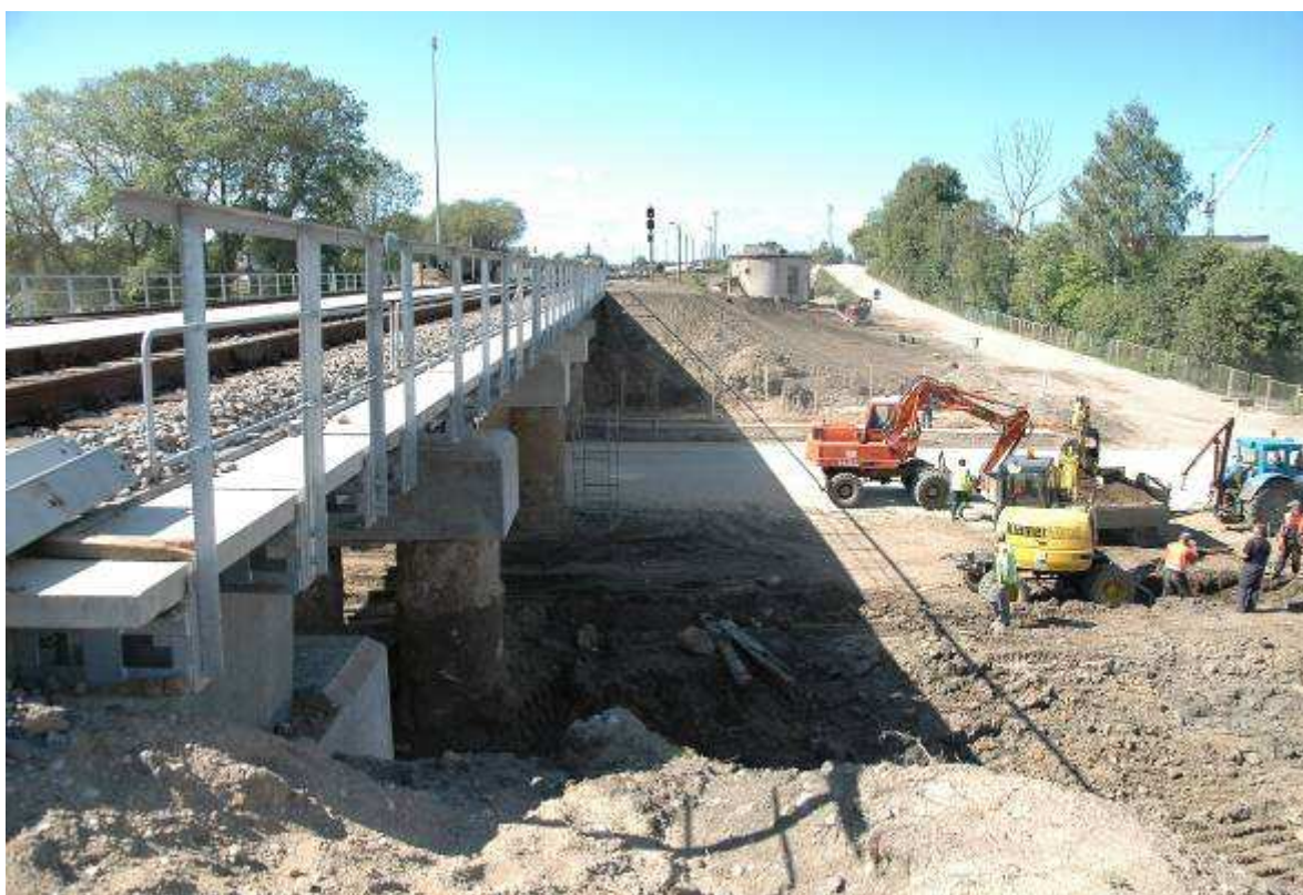
3.1.3.3 pav. Geležinkelio viaduko įrengimo darbai (šalia – laikinas viadukas) (Liepų g.)
