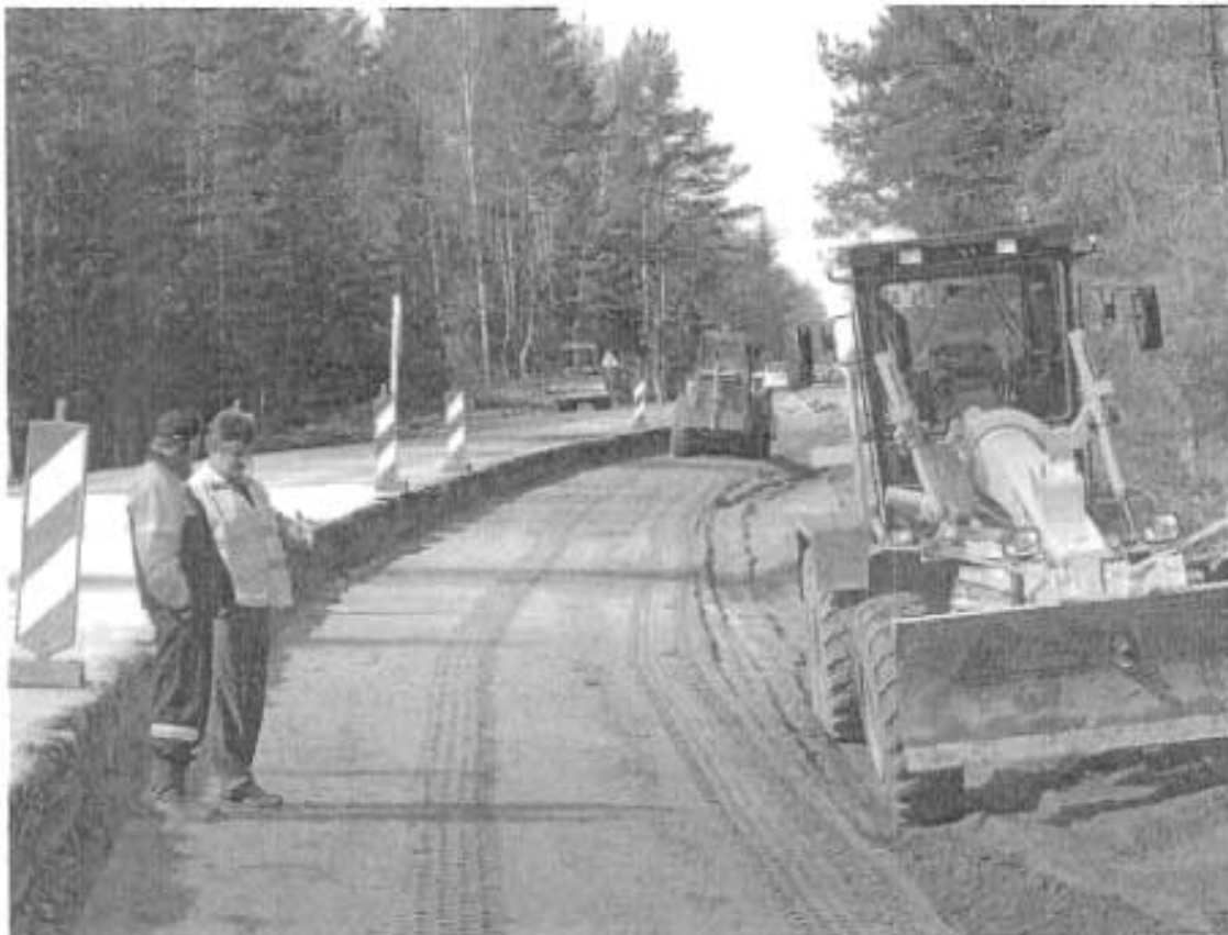
3.1.3.1 pav. Žemės sankasos įrengimas Pk 414 – 418, dešinėje pusėje
