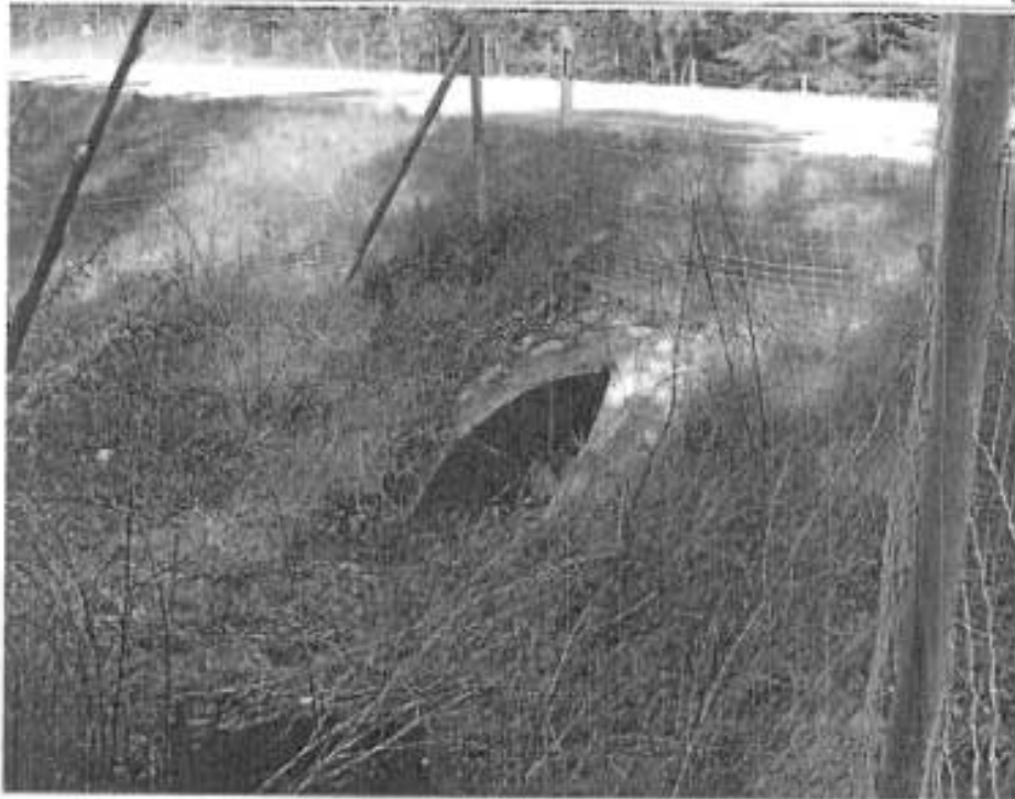
7.5.1.2 pav. 41,66 km. Požeminė perėja smulkiems miško gyvūnams (2008-05)
