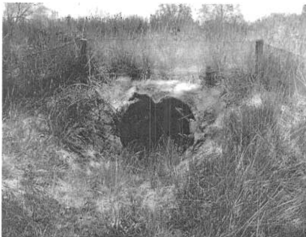
7.5.3.2 pav. 49,64 km, kelio kairė pusė. Požeminė perėja varliagyviams (2008-05)
