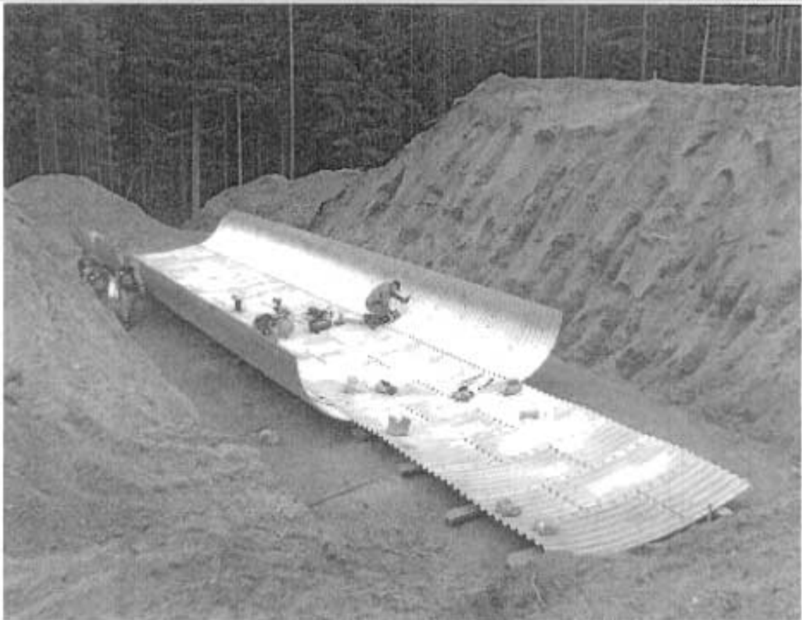
3.1.3.4 pav. Metalinės \varnothing 3,6 m pralaidos montavimas Pk 443+75
