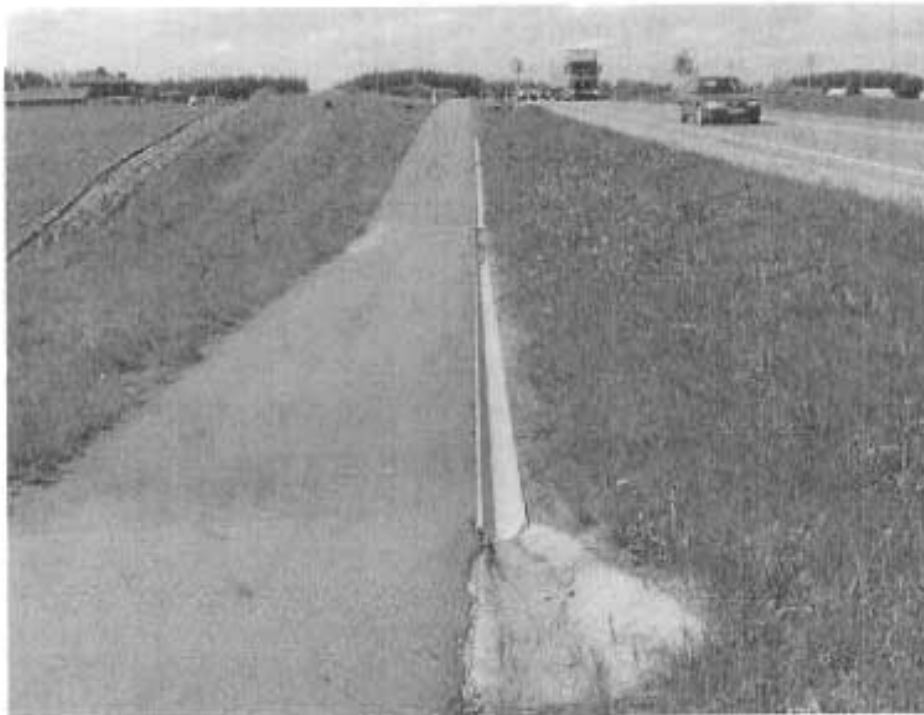
7.4.2.1 pav. 28,95 km. Paviršinių nuotekų surinkimo sistema (2008-05)
