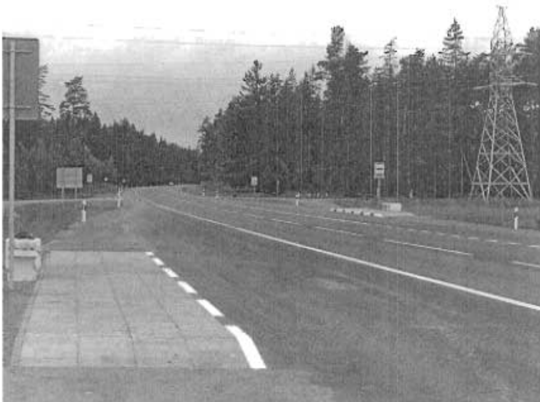
3.1.4.3 pav. Autobusų sustojimo aikštelės, naujai įrengta dangą ruože 15,55-22,58 km
