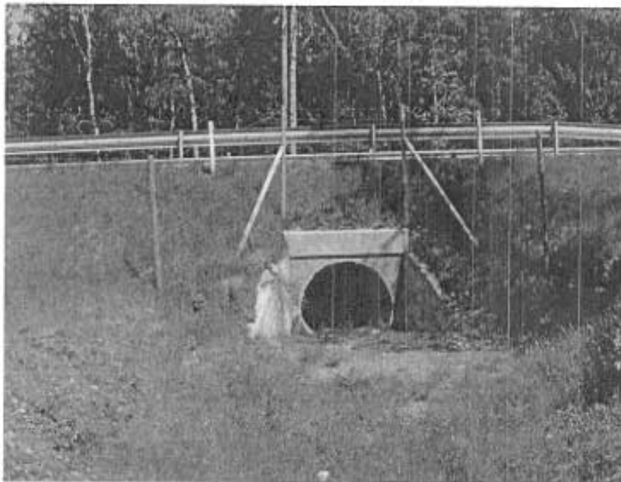
7.5.1.3. pav. 42,17 km. Požeminė perėja smulkiems ir vidutiniams miško gyvūnams (2008-05)
