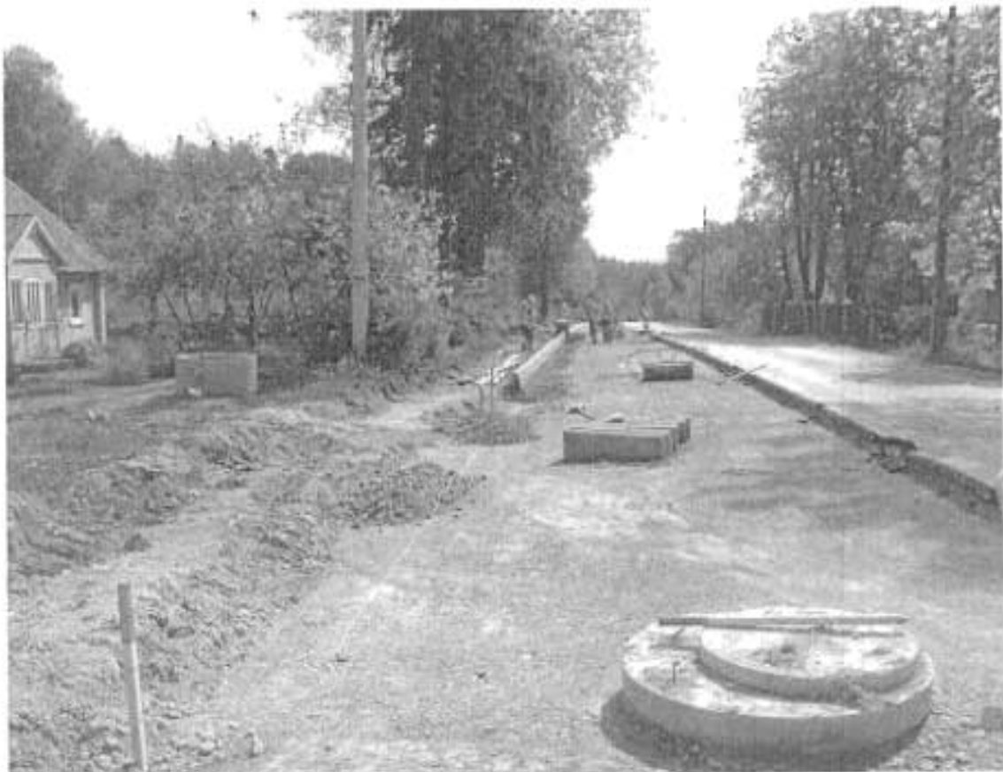
3.1.3.3 pav. Kelio bortų įrengimas Aukštadvaryje, Vilniaus gatvėje
