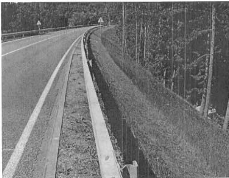
7.4.3.2 pav. 43,5 km, kelio dešinė pusė. Betono blokelių bortelis nukreipia nuotekų srautą į sankasos šlaite įrengtus sėdinimo šulinius (2008-05)
