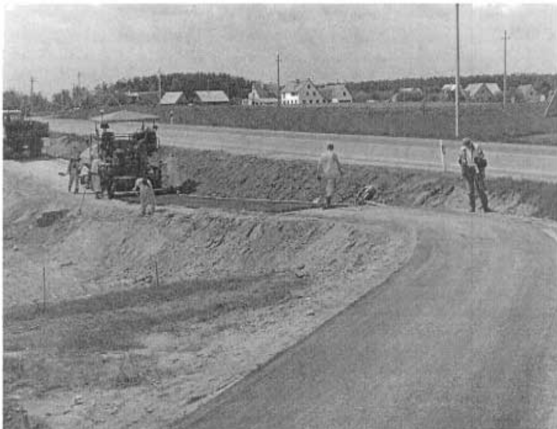
3.1.3.5 pav. Asfaltbetonio dangos klojimas pėsčiųjų ir dviračių take 28,74 – 29,51 km
