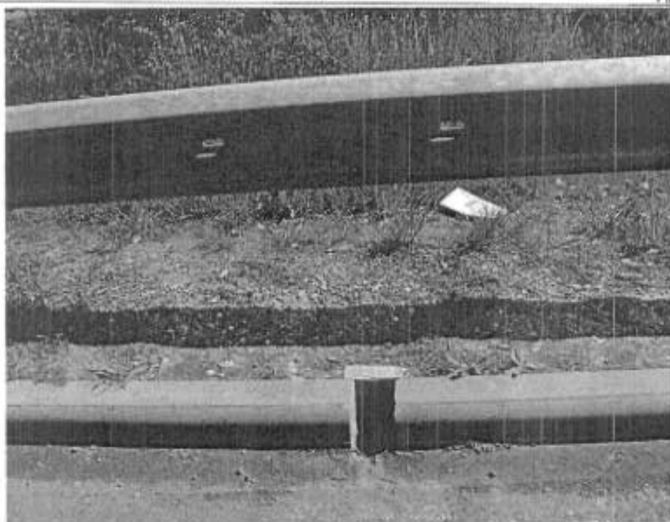
7.4.3.4 pav. 45,85 km, kelio kairė pusė. Betoninių blokelių bortelis, jame matoma paviršinių nuotekų nuleidimo vamzdžio anga (2008-05)
