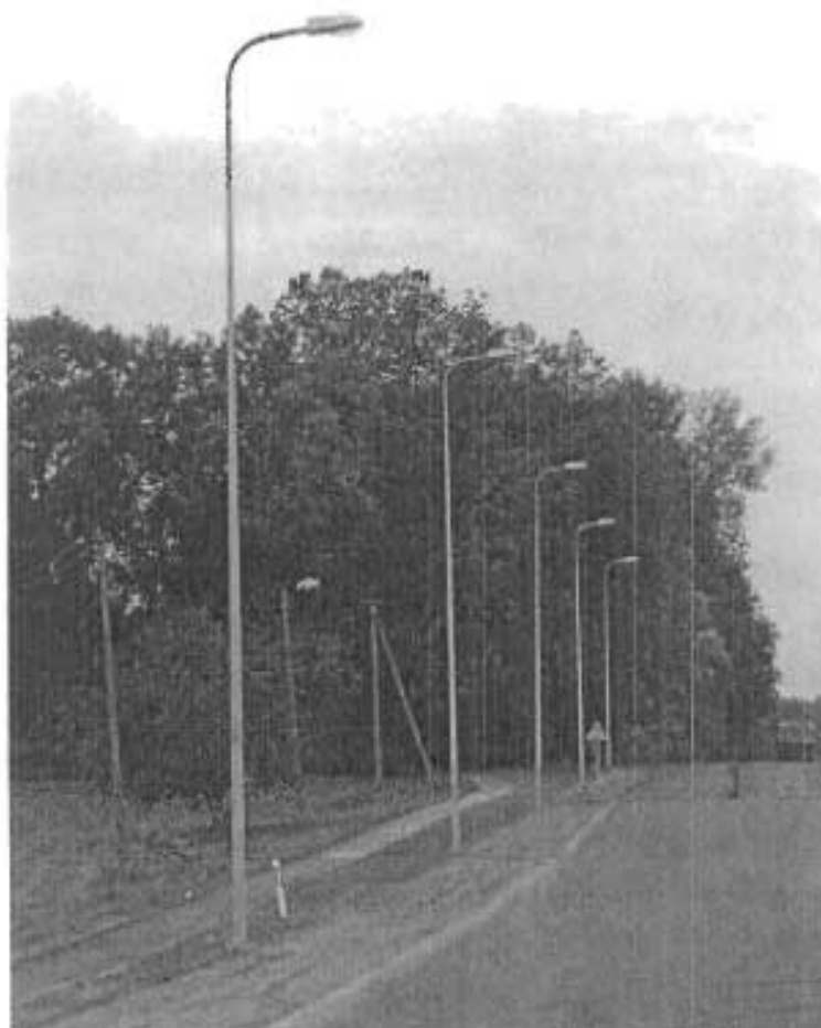
3.1.4.4 pav. Įrengtas pėsčiųjų takas ir apšvietimas Aukštadvaryje
