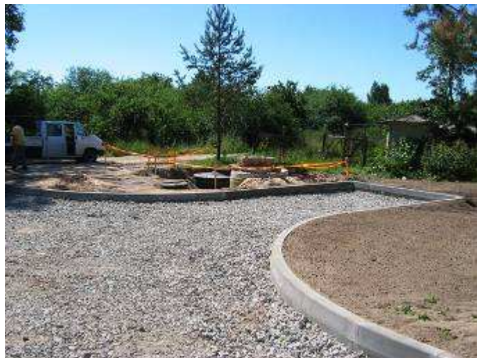
Nuotekų siurblinės NS-7 montavimo darbai Transporto g.
