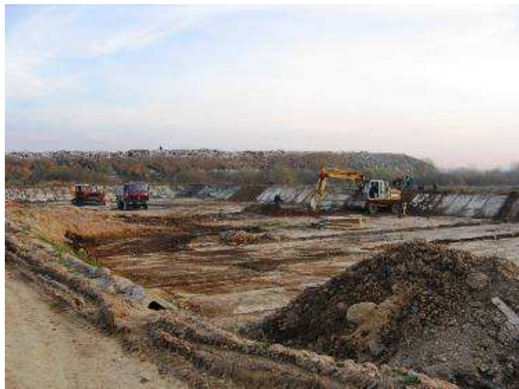
Dumblo aikštelių dugnų įrengimo paruošiamieji darbai. Drenažinio latako betonavimo darbai
