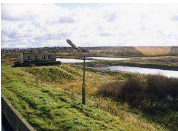
Aeraciniai tvenkiniai su filtrų pastatu kairėje
