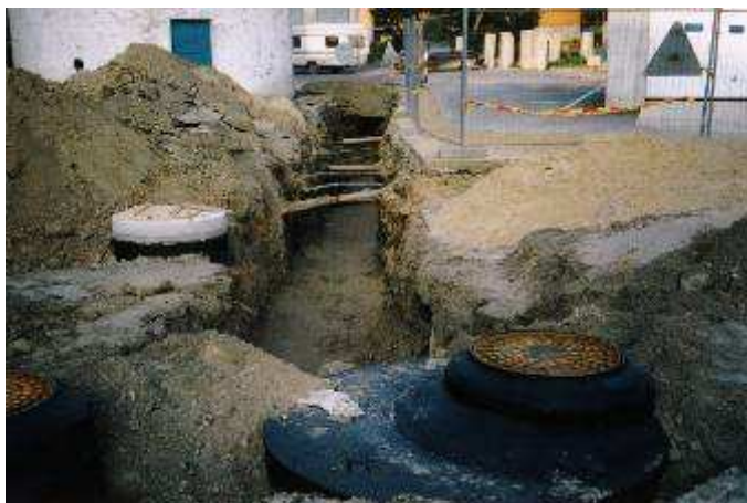
Savitakinių nuotekų tinklų prie nuotekų siurblynės NS-2 montavimas Maironio gatvėje
