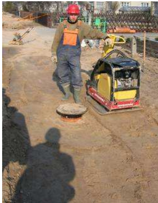
Nuotekų linijos tiesimo darbai Draugystės gatvėje
