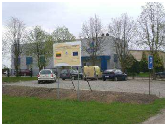
Administracinis pastatas su dispečerine po rekonstrukcijos
