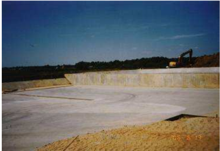
Užbaigti dumblo saugojimo aikštelių dugno konstrukcijų betonavimo darbai
