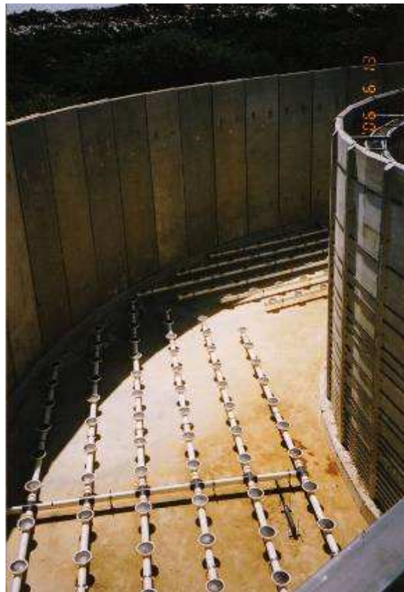
Reaktoriaus-nusodintuvo aeracinės sistemos sumontavimas
