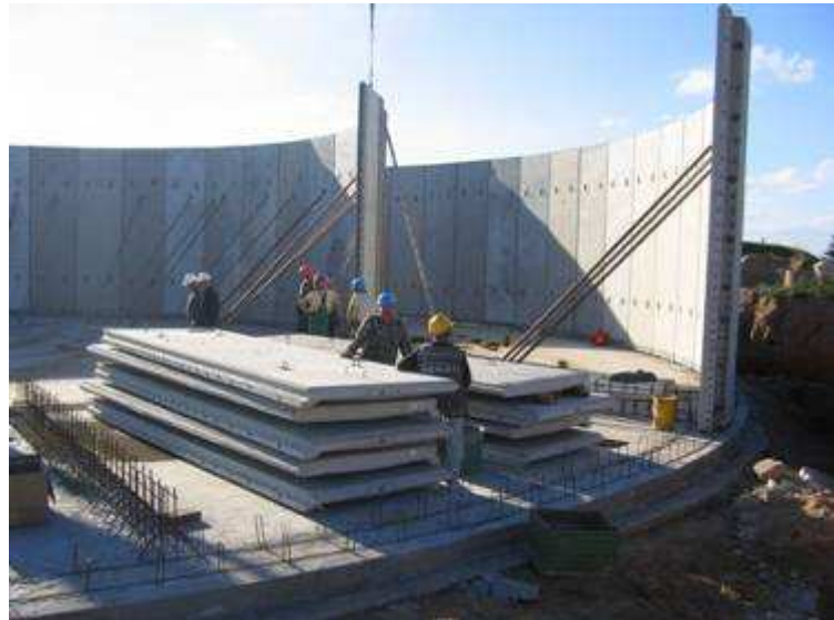
Pirmojo ir antrojo rezervuarų sieninių plokščių montavimo darbai
