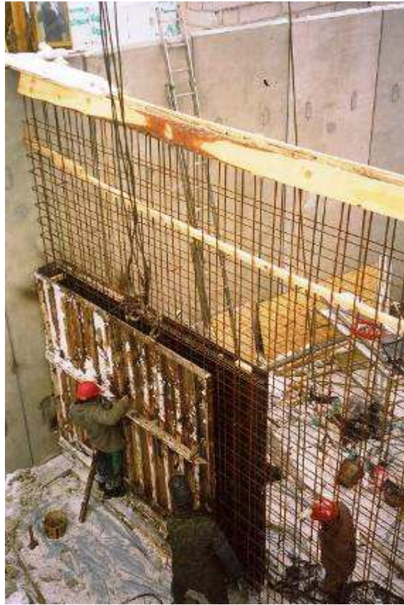
Vidinių atitvarų klojinių montavimo darbai reaktoriuje-nusodintuve Nr.1
