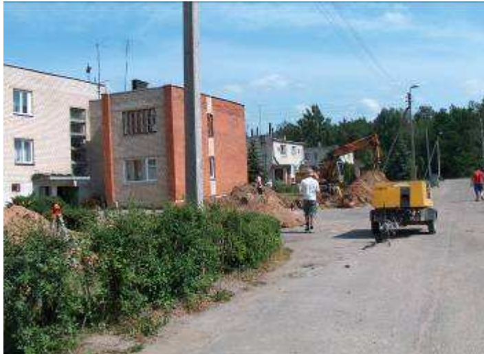
Vandentiekio ir nuotekų tinklų tiesimo darbai Miško kvartale
