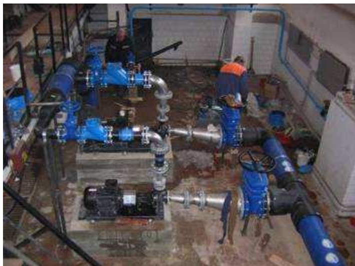
II kėlimo siurblinės rekonstrukcijos darbai
