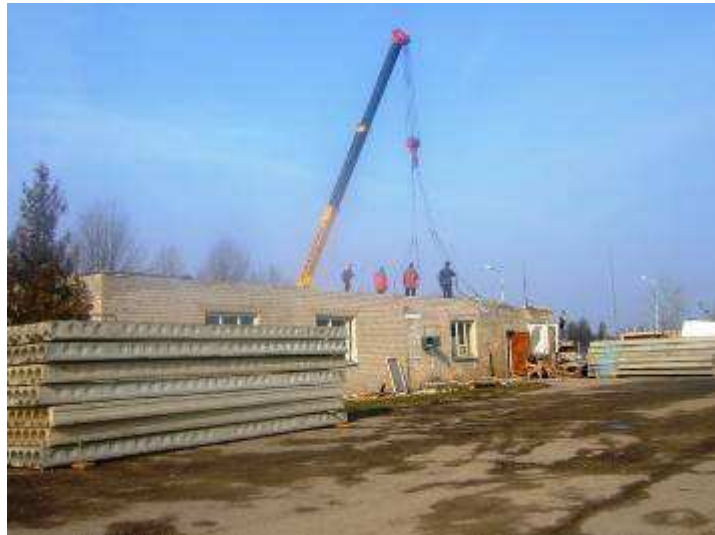
Administracinio pastato rekonstrukcijos darbai
