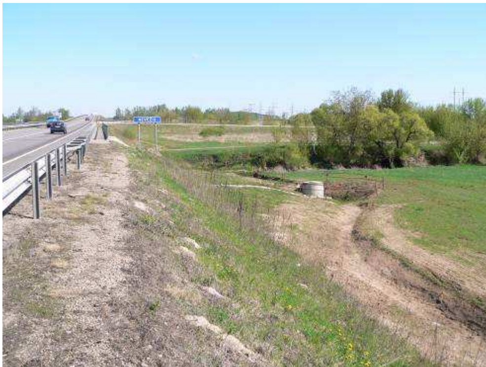
7.7.2.2 pav. Rekonstruotas vandens valymo įrenginys, kelio dešinėje, 11,8 km (2006 m. gegužės mėn.)
