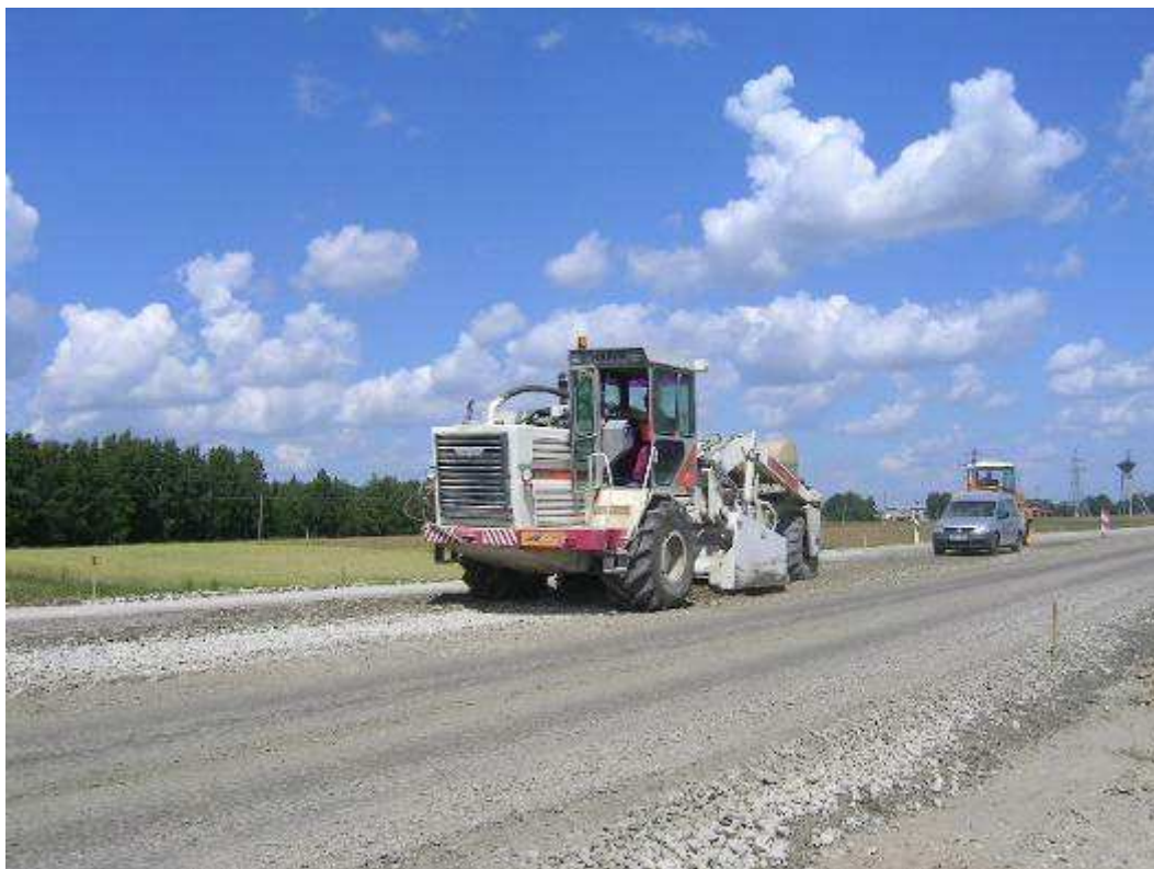
3.1.3.1 pav. Senos kelio dangos paruošimo asfaltavimui darbai, kelyje A10 Panevėžys-Pasvalys-Ryga, ruožas 32,89–38,70 km
