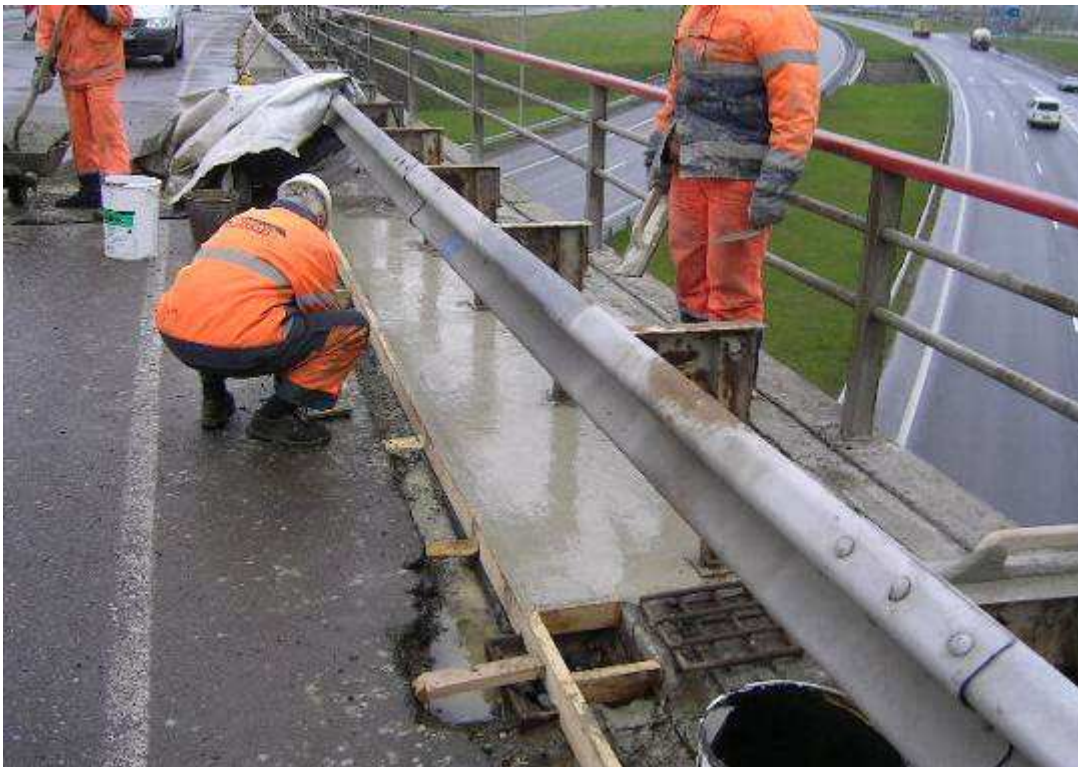
3.1.3.8 pav. Sargėnų viaduko rekonstravimo darbai kelyje A5 Kaunas-Marijampolė-Suvalkai
