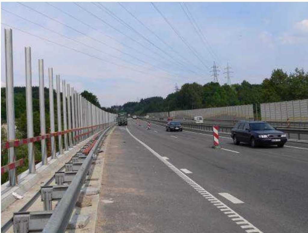
7.5.2.1–7.5.2.2 pav. Triukšmą mažinančios sienutės ant estakados per Raudondvario plentą įrengimo darbų metu (2006 m. rugpjūčio mėn.)
