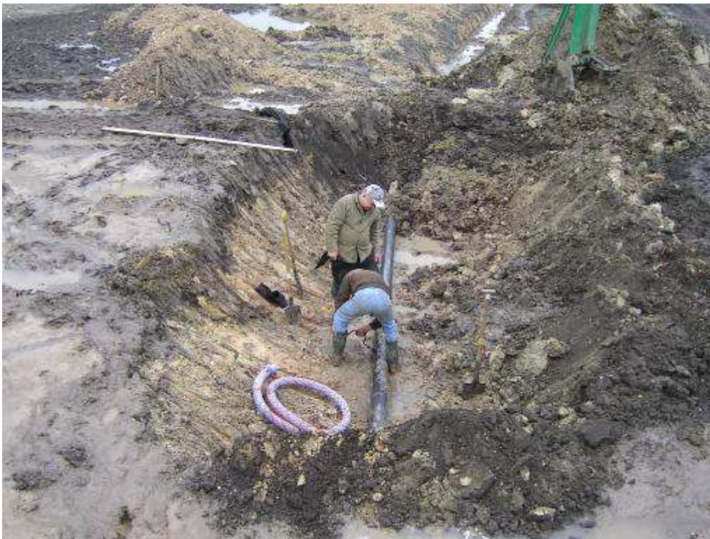
3.1.3.5 pav. Sausinimo sistemų rekonstravimo darbai kelyje A10 Panevėžys-Pasvalys-Ryga
