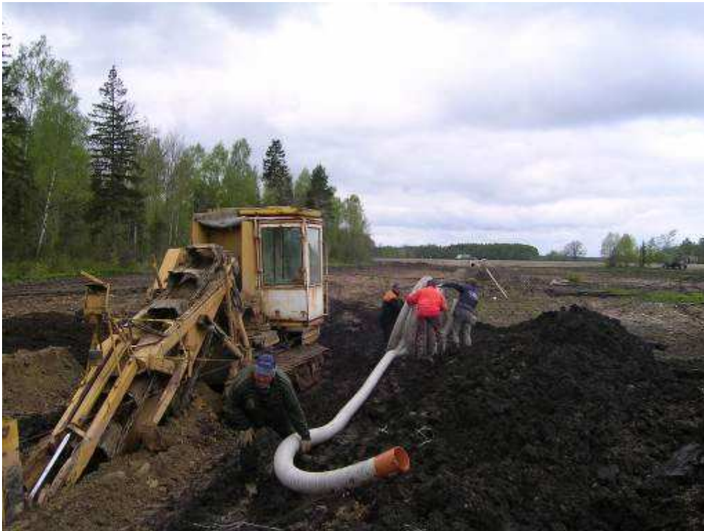
3.1.3.4 pav. Sausinimo sistemų rekonstravimo darbai kelyje A10 Panevėžys-Pasvalys-Ryga
