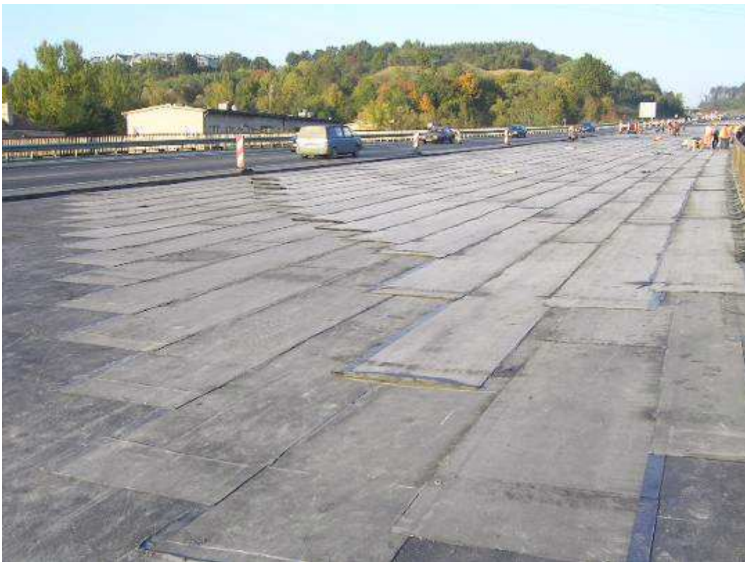
3.1.3.9 pav. Kelyje A5 Kaunas-Marijampolė-Suvalkai estakados per Raudondvario plentą rekonstravimas (2005 m. spalio mėn.)
