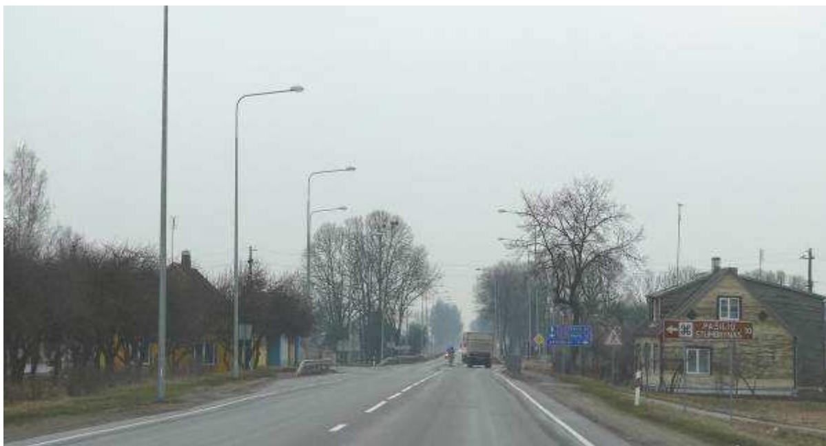
3.1.4.1 pav. Kelio A8 Panevėžys-Aristava-Sitkūnai 24,5–26,1 km ruože įrengtas kelio apšvietimas Ramygalos gyvenvietėje
