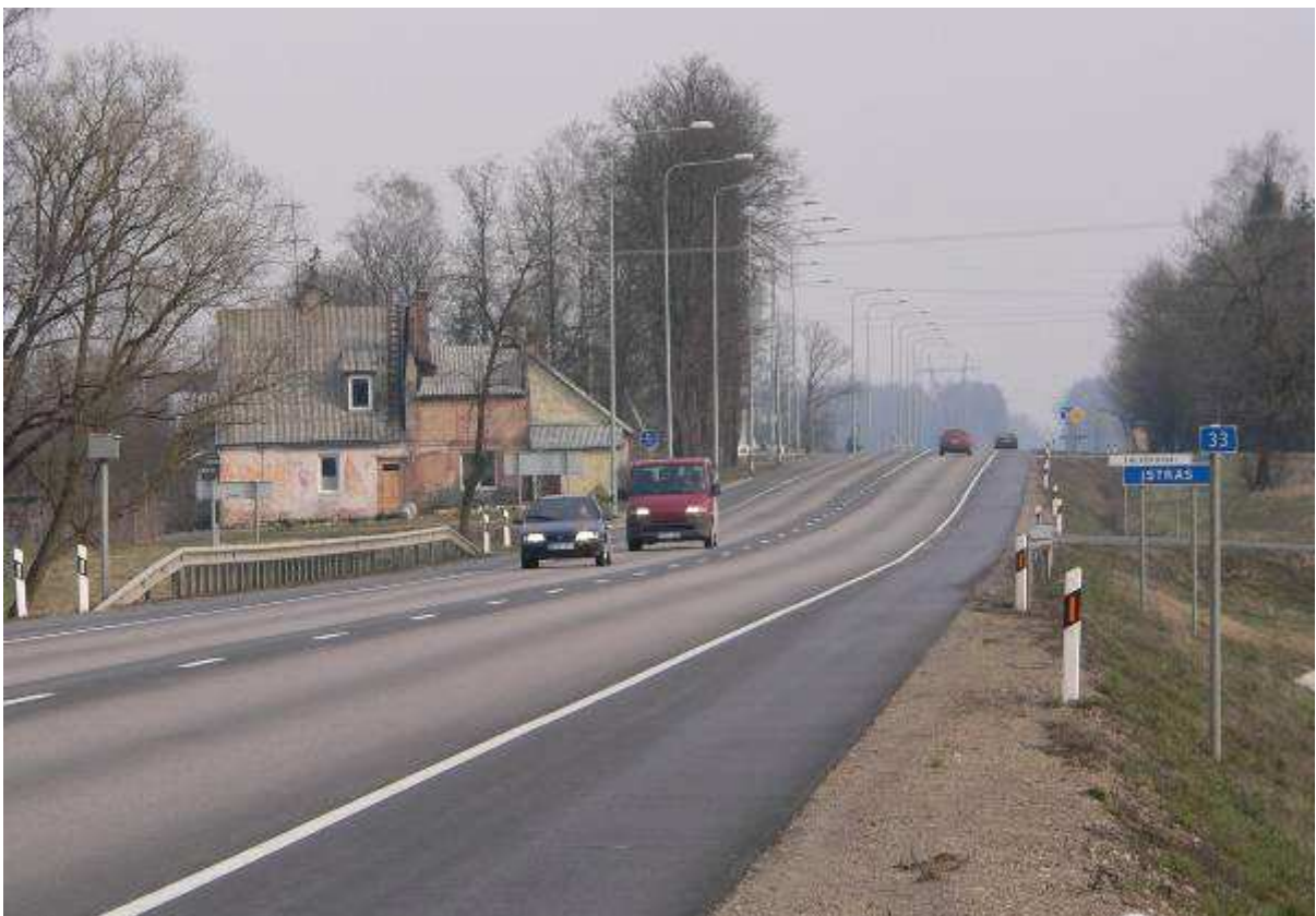
3.1.4.3 pav. Kelio A10 Panevėžys-Pasvalys-Ryga 23–24,7 km ruože atliktas dangos stiprinimas ir platinimas, dešinėje kelio pusėje, ir apšvietimo įrengimas per Pumpėnų gyvenvietę
