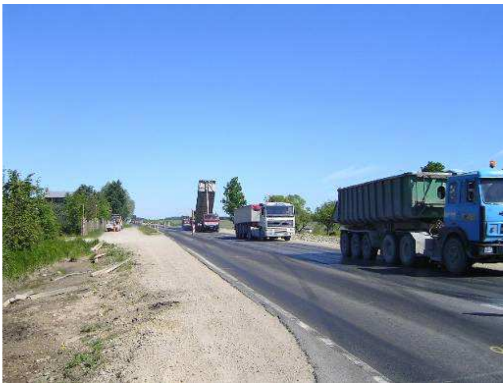
3.1.3.6 pav. Asfaltbetonio dangos įrengimo darbai kelyje A10 Panevėžys-Pasvalys-Ryga
