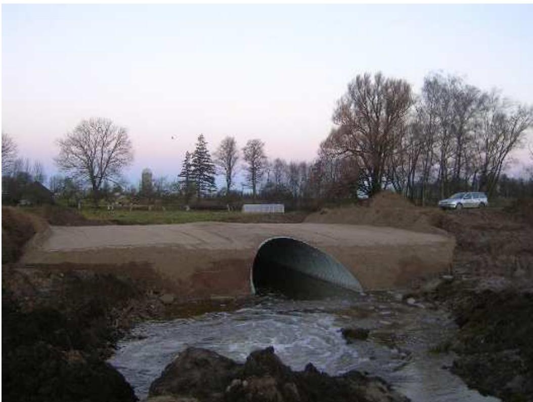
3.1.3.3 pav. Metalinės pralaidos įrengimas kelio A10 Panevėžys-Pasvalys-Ryga 33,07 km
