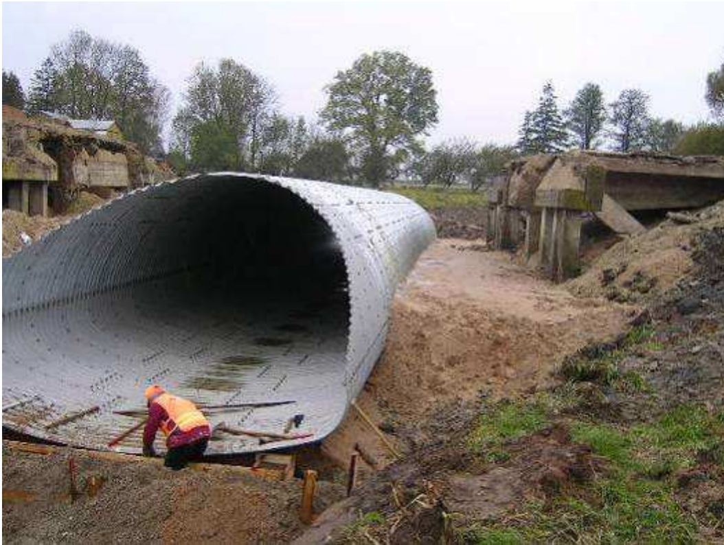
3.1.3.2 pav. Metalinės pralaidos įrengimas kelio A10 Panevėžys-Pasvalys-Ryga 33,07 km
