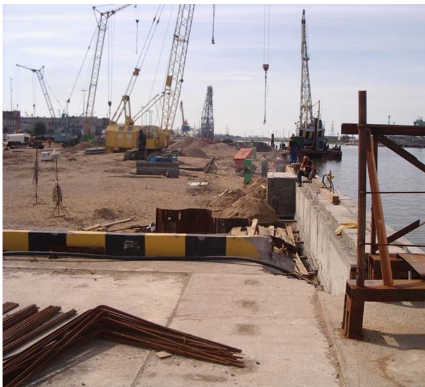
2 pav. Šiuo metu rekonstruojamos krantinės Nr.105-106
